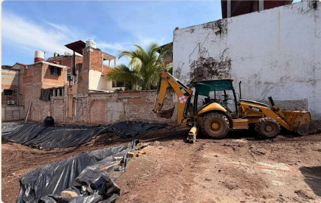
MAQUINARIA DE EXCAVACIÓN EN OBRA
