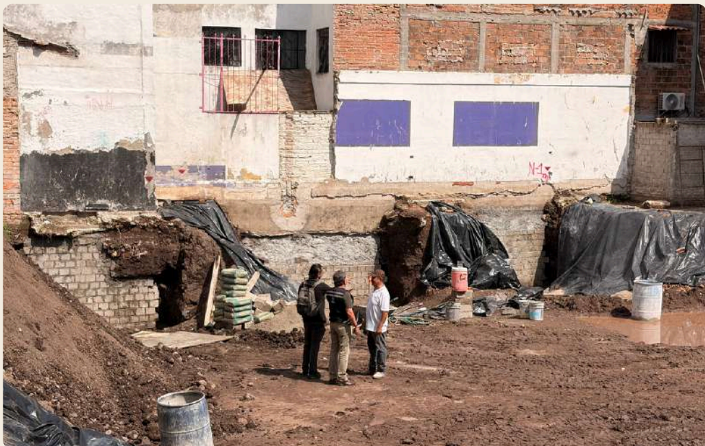
TRABAJOS DE EXCAVACIÓN
