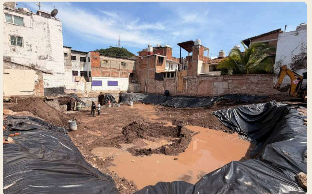
VISTA GENERAL DE OBRA
