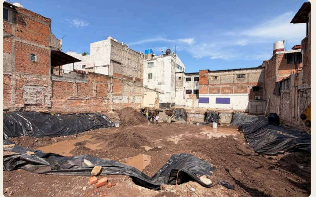
VISTA GENERAL DE OBRA
